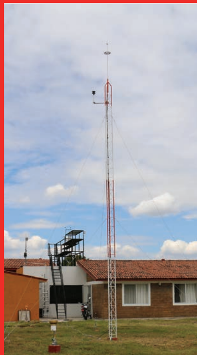
Estación solarimétrica en Coeneo, Mich, en el Observatorio de Centelleo Interplanetario del Instituto de Geofísica.
