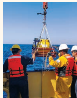
La instalación de sismómetros de fondo marino.
